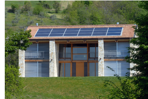
Impianto FV integrato
