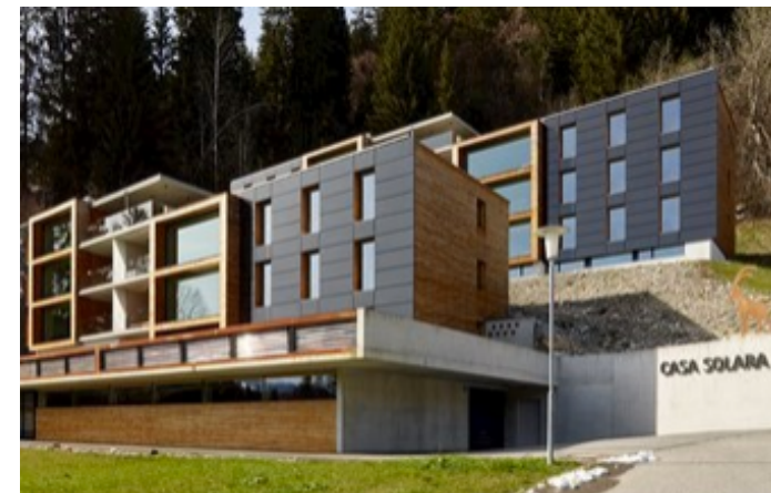
Impianto FV su facciata
