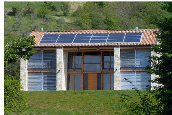
Impianto FV integrato
