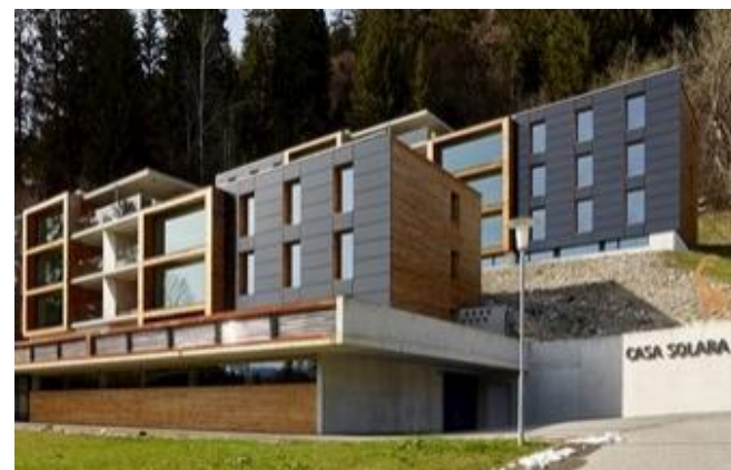
Impianto FV su facciata
