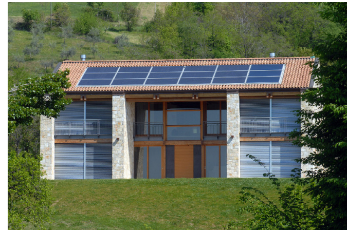
Impianto FV integrato
