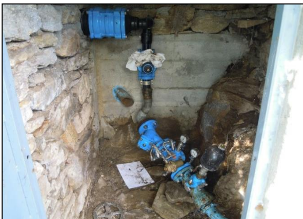
Riduttore di pressione "Pergole" da eliminare
