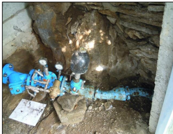
Riduttore di pressione "Pergole" da eliminare
