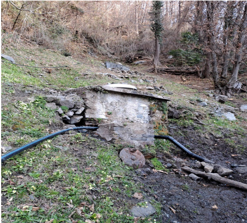
Foto 7: camera di raccolta sorgenti Gordola
