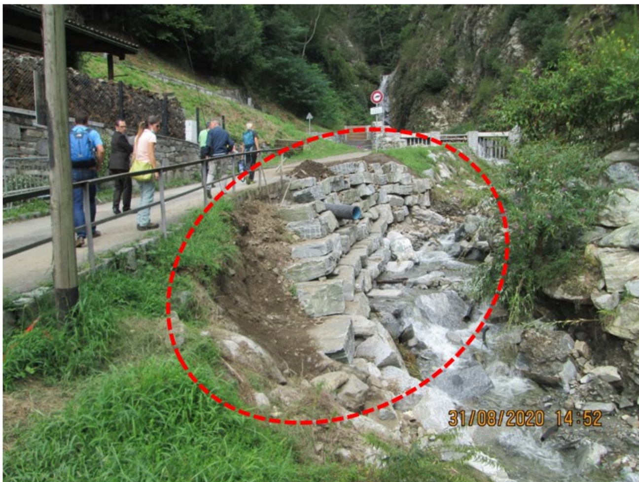
FOTO 3 Rinforzo argine e campo stradale (blocchi da cava riutilizzati per intervento in oggetto)
