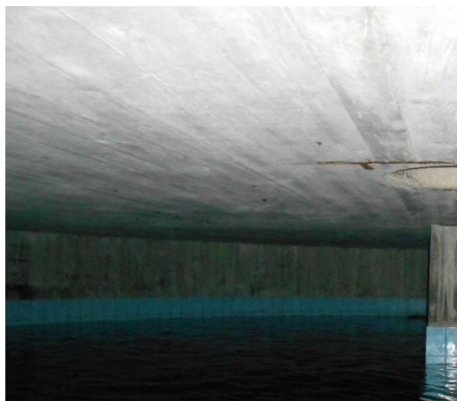
Figura 13 - Copriferro soletta di copertura
