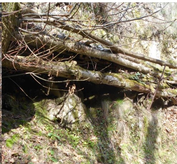
Figura 29 - Sentiero di accesso a valle della camera UV (2)
