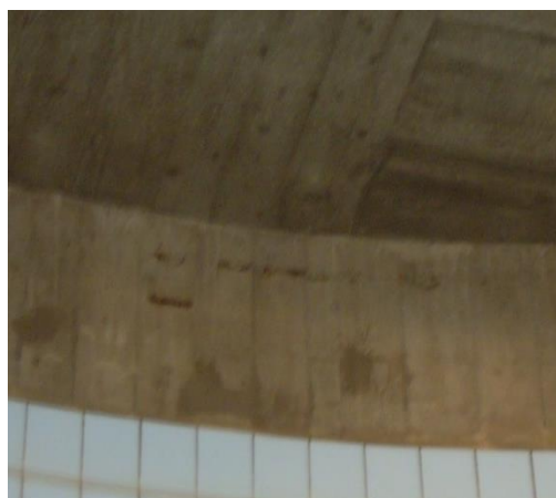
Figura 14 - Copriferro pareti perimetrali vasca
