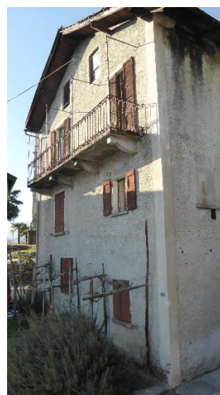
Mappale numero 2580 subA. Edificio da demolire
