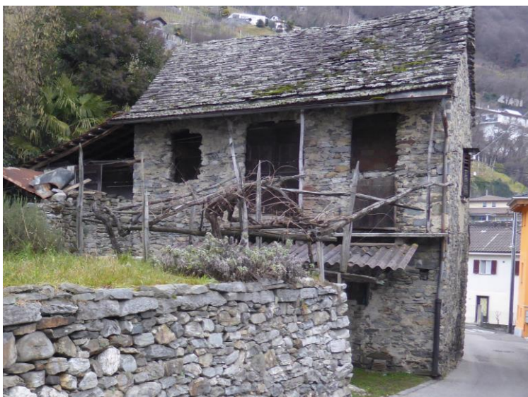
Mappale numero 2582 RFD subA. Edificio da demolire
