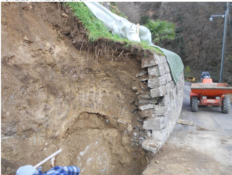
10.12.2014 inizio dei lavori
