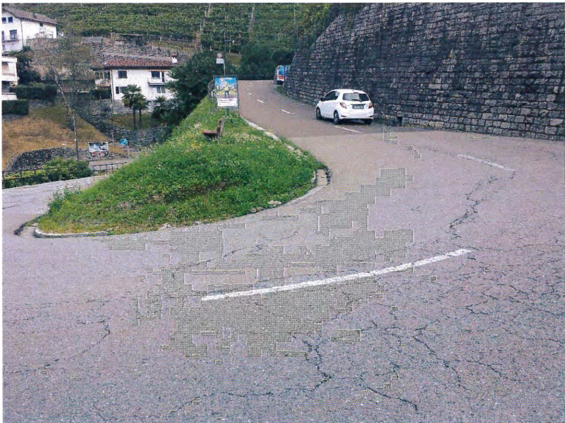
Foto 8– Dal tornante a monte, visto verso monte
