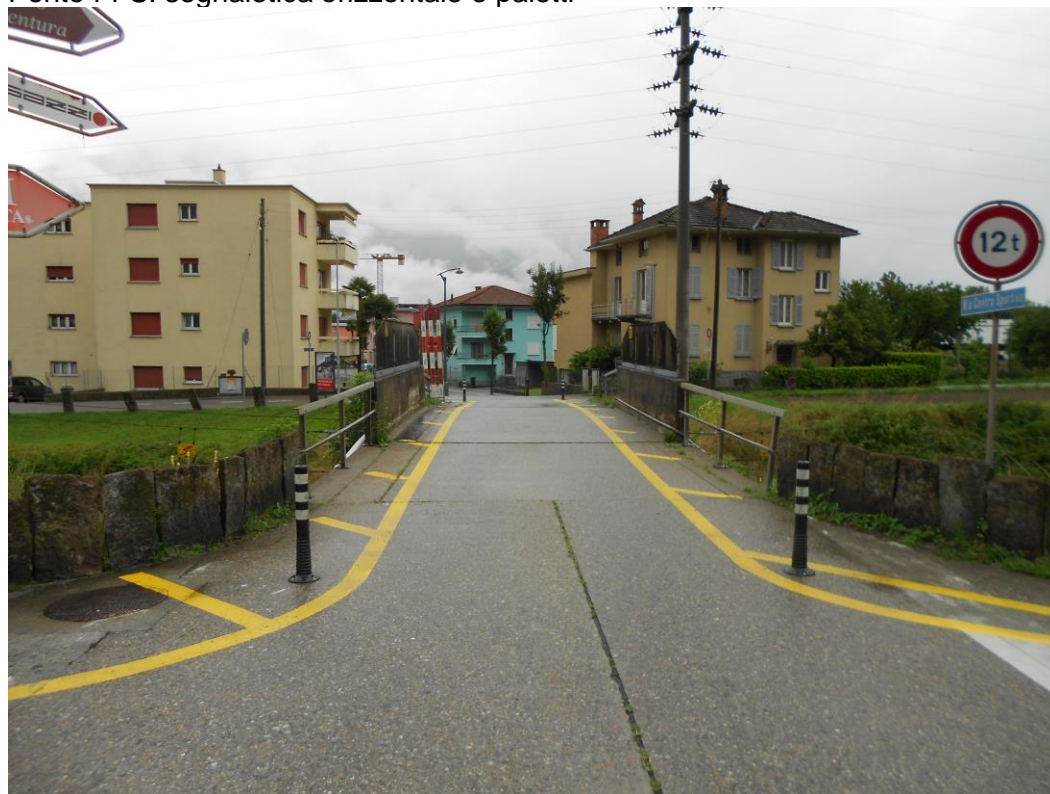
Ponte FFS: segnaletica orizzontale e paletti
