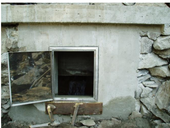
Captazione sorgente no. 2 ricostruita provvisoriamente
