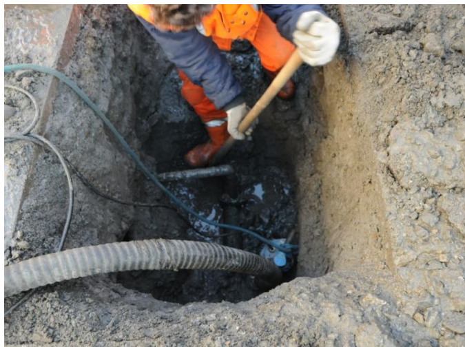
Figura 2 Riparazione perdita allacciamento utente
